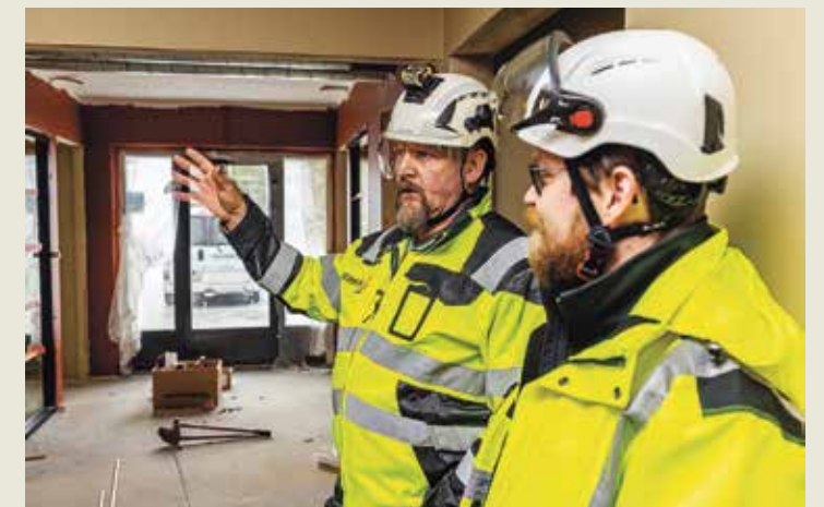
Tommi Salo on tyytyväinen rakennushankkeen etenemiseen. Henkilöstön on tarkoitus muuttaa tiloihin toukokuun alussa.
