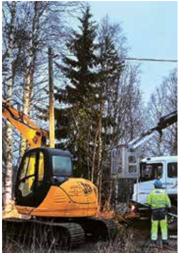
Vetelin Energian toimialueen johtokatuja alla tehdään tällä hetkellä raivaustöitä.
